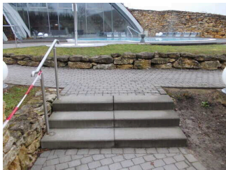
Stufen zum Abkühlbereich der Außensaunen
