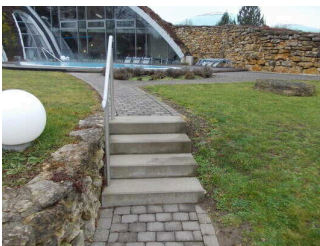
Treppe im Außenbereich der Sauna
