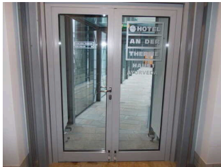
Tür am Übergang zum Hotel an der Therme
