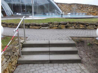
Stufen zum Abkühlbereich der Außensaunen
