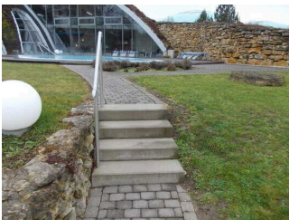
Treppe im Außenbereich der Sauna
