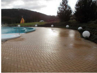
Wege im Außenbereich zum Schwimmbecken
