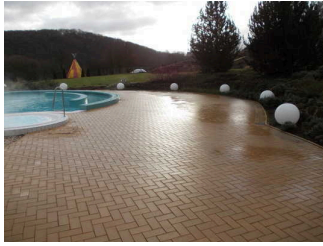
Wege im Außenbereich zum Schwimmbecken
