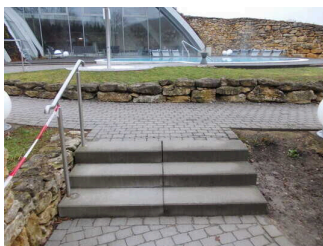
Stufen zum Abkühlbereich der Außensaunen
