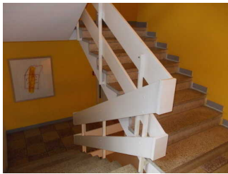
Treppe alle Etagen
