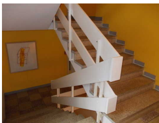
Treppe alle Etagen
