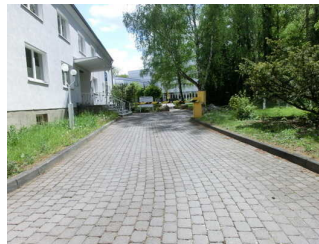
Fußweg ab Seiteneingang zum Haupteingang mit 7% Steigung auf 6 Meter
