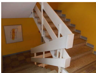
Treppe alle Etagen
