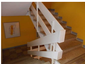
Treppe alle Etagen
