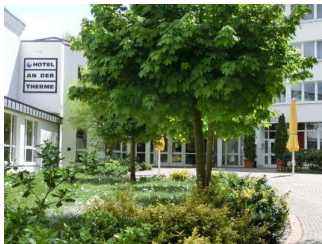
Hotel an der Therme – Haus 1
