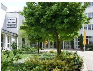
Hotel an der Therme – Haus 1
