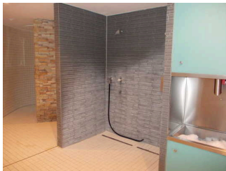
Abkühlbereich der Innensaunen
