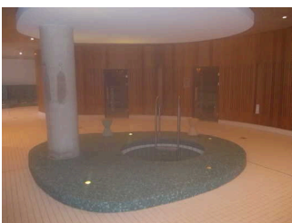
Wege im Saunabereich
