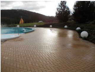
Wege im Außenbereich zum Schwimmbecken
