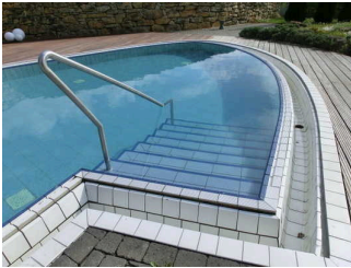
Außenbecken im Saunabereich
