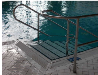
Einstieg ins Becken mit Abstellmöglichkeiten für Gehhilfen und Langstöcke
