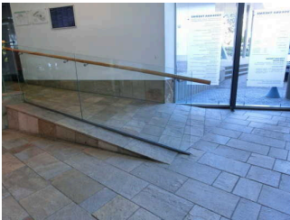
Rampe zur Kasse
