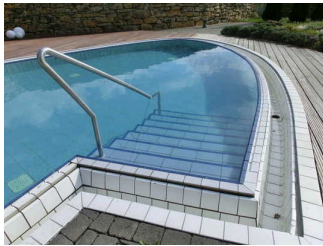
Außenbecken im Saunabereich
